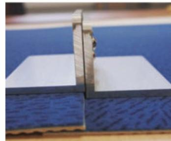
耳をカットした床材の上に重ねてガイドにして下の床材をカットする事ができます。
